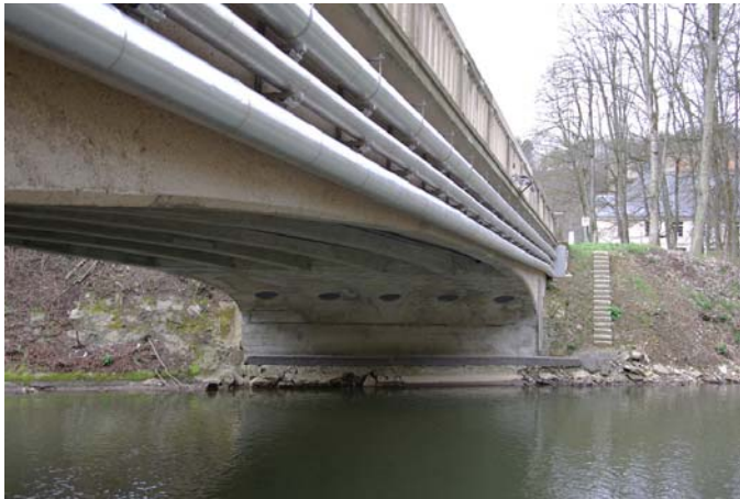
Untere Neckarbrücke Neckartal
